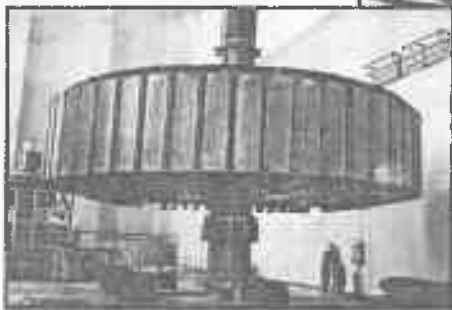
Подъем и перемещение ротора производится с помощью мостового крана с грузоподъемностью 250 т.с.
