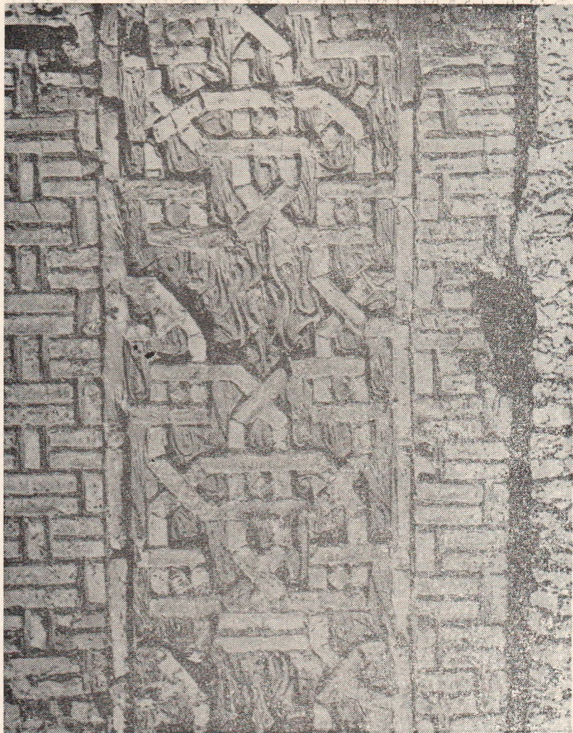
Рис. 25. Северный мавзолей. Деталь орнаментальной кладки.
