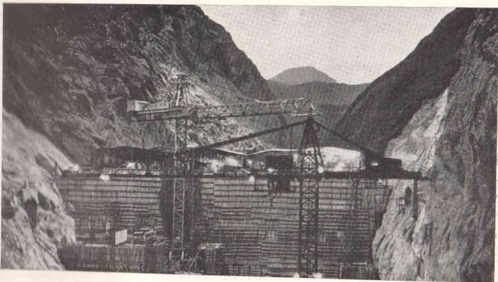
Плотина Токтогульской ГЭС.
