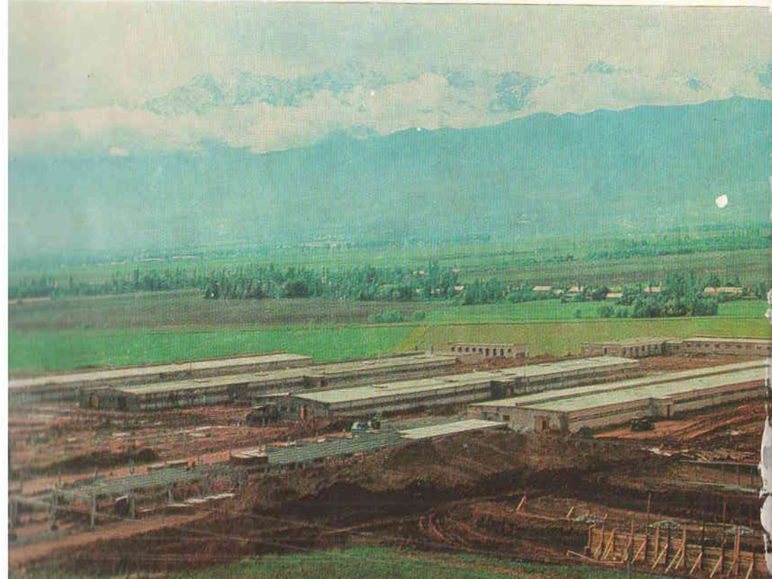
Строящийся телочный комплекс в Наукатском районе.
