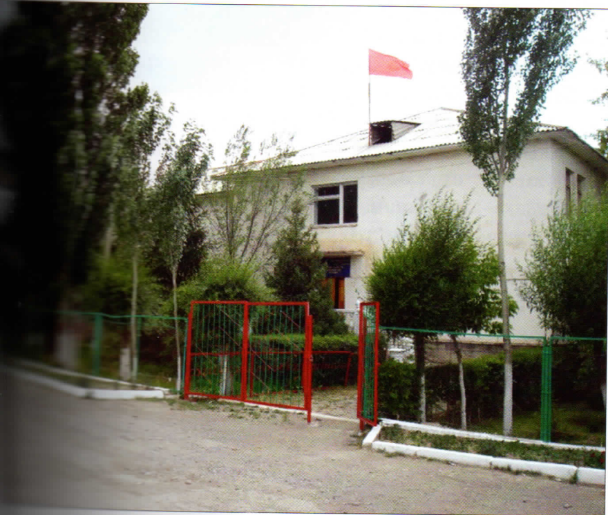
1996-жылы облустук архив ушул имаратка көчүрүлгөн. Кыргыз Республикасынын Архив кызматкерлеринин 70 жылдык маарымына карата 1996-жылы облустук архивдин имаратынын капиталдык ремонттон кийинки көрүнүшү (2000-жыл).
