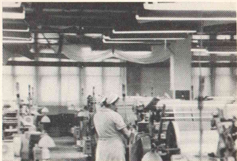
Ткацкий цех. В работе ткацкие станки П-125А.
