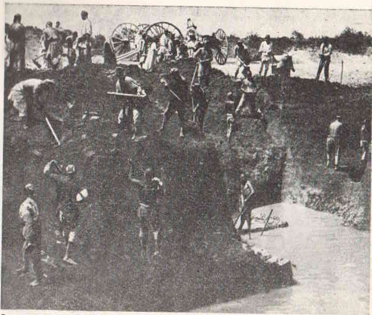
Работы по прорытию канала у станции Серова.
