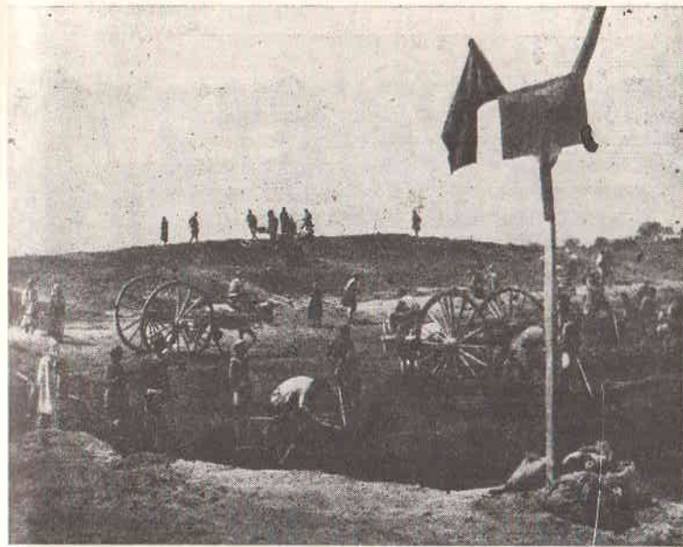
Сооружение дамбы на 29-м участке у к. Каны-Джамага.
