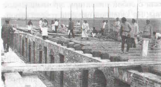
«Интергельпо» на строительстве хирургической больницы.
