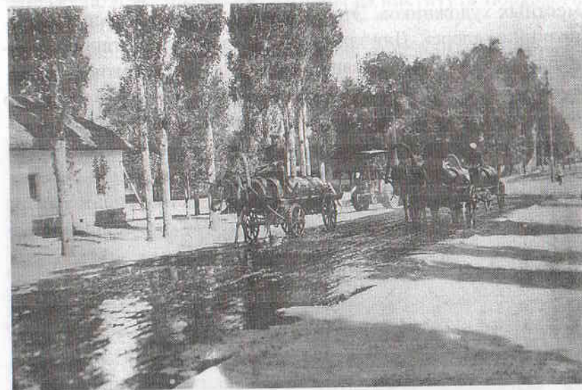
Асфальтирование городской улицы
