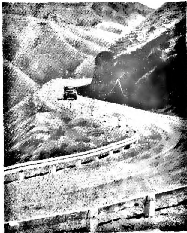
Автомобиль жолу Фрунзеден Рыбачьеге алып барат. В Рыбачье приводит автомобильная магистраль из Фрунзе (176 км). На последнем своем участке она протянулась вдоль Чу по известному Боямскому ущелью — узкому проходу между хребтами Киргизским и Кунгей-Алатау.
