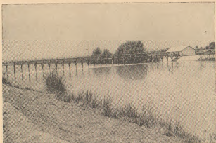
Голодностепский магистральный канал в Узбекистане близ Мирзачуля
