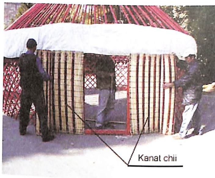
7. «Канат-чий» устанавливается по «кереге» вокруг юрты
