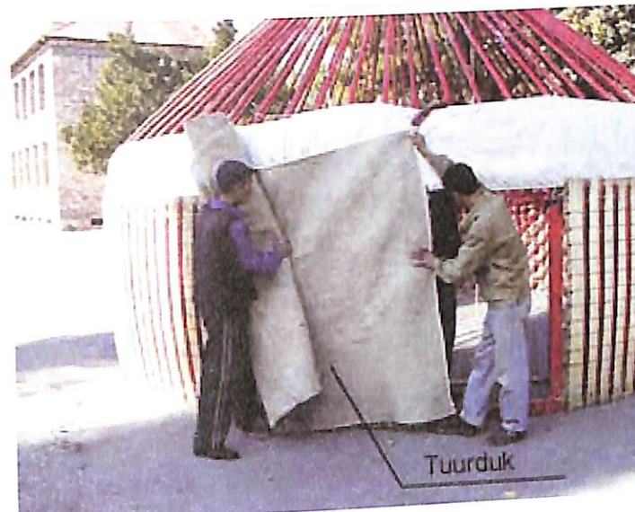
9. «Туурдук» закрепляется по середине арканом «бел-кырчоо».
