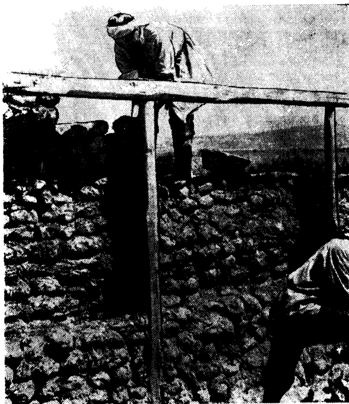
Рис. 101. Кладка стены из глиняных комков «гу» Наукатский р-н.
